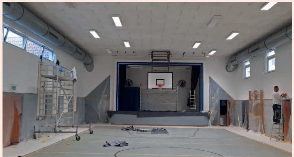
Blick auf die Reparatur- und Malerarbeiten in der Turnhalle.
